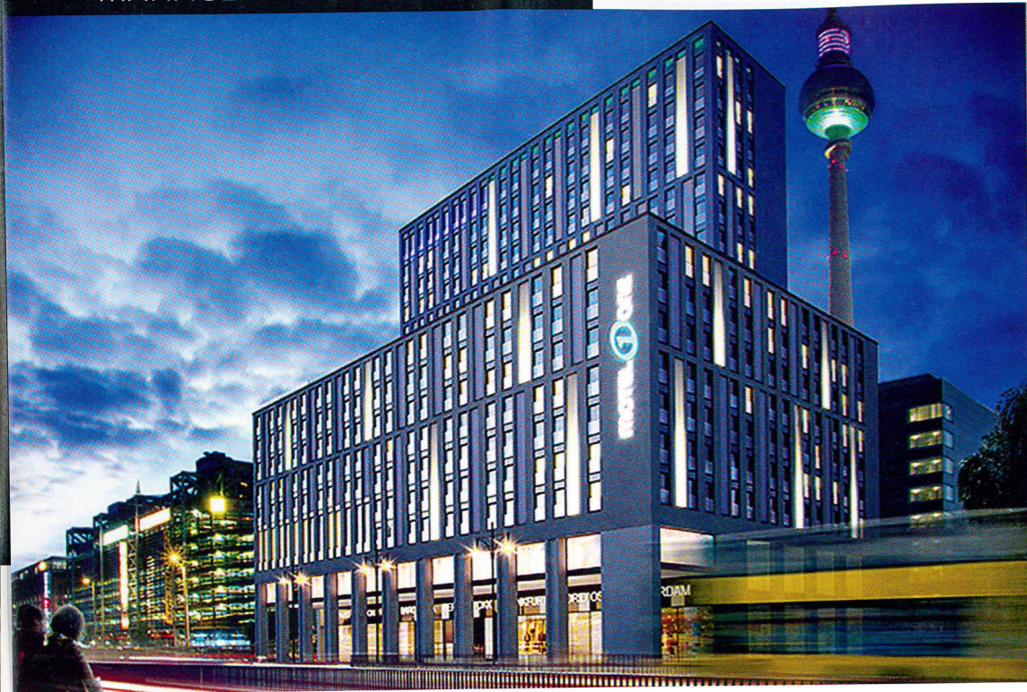
Es wird das größte seiner Art: Mit 708 Zimmern auf 19 Etagen und einem Investitionsvolumen von 95 Millionen Euro will Motel One in Kürze am Alexanderplatz an den Start gehen
